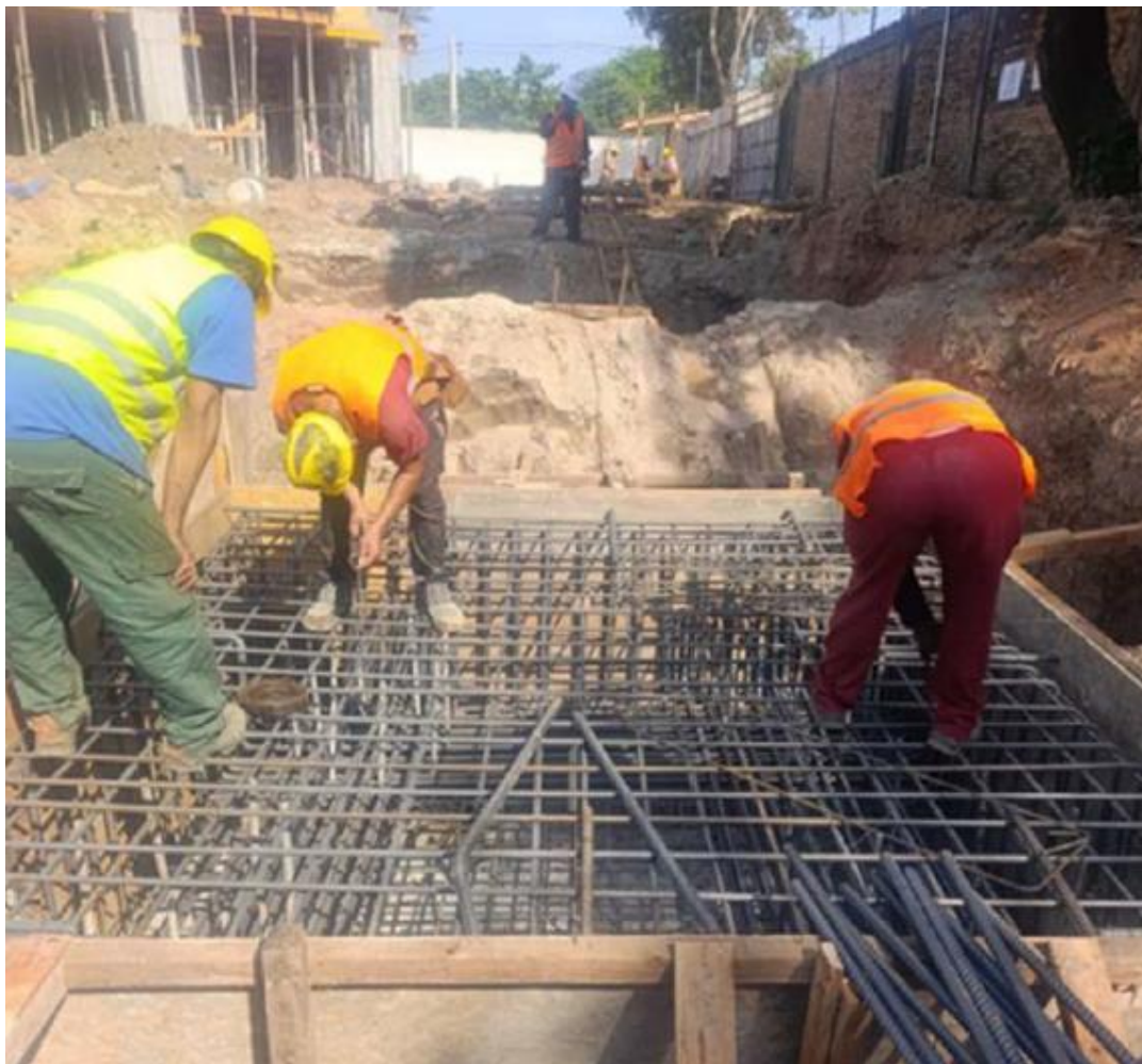
Preparación de armaduras y encofrado para cabezales
