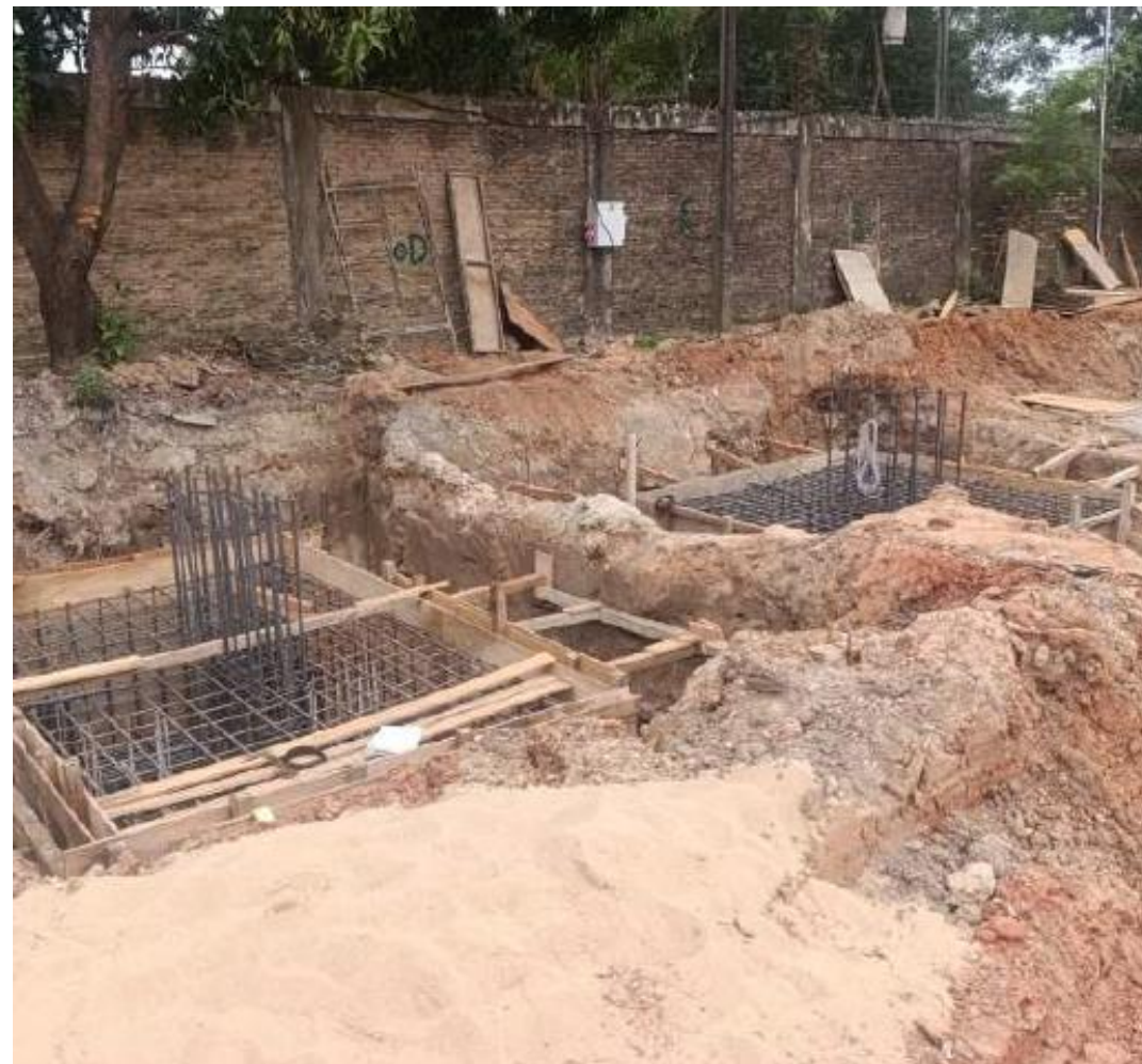
Preparación de armaduras y encofrado para cabezales
